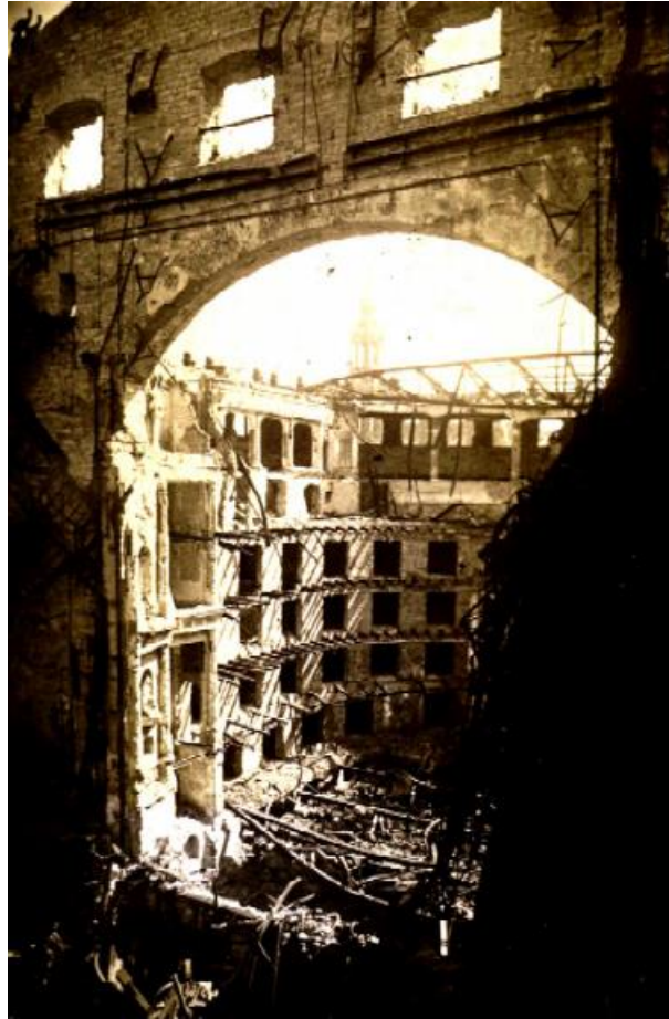
Bild 3: Blick in den Zuschauerraum
