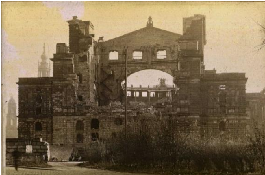
Bild 4: Blick von der Bühnenseite auf die Ruine
